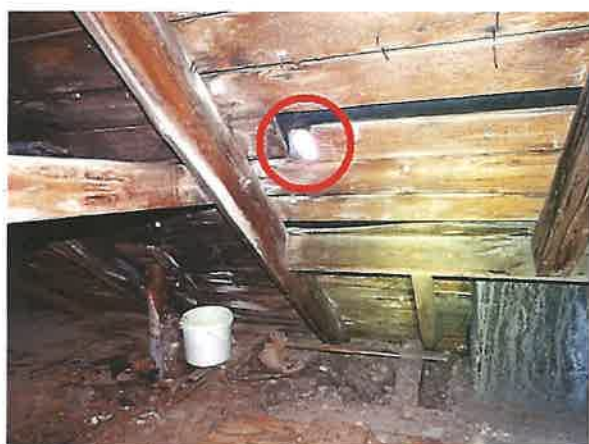
č. 21 – 22 Budova A, celkový pohled a detail otvoru v střešním plášti
