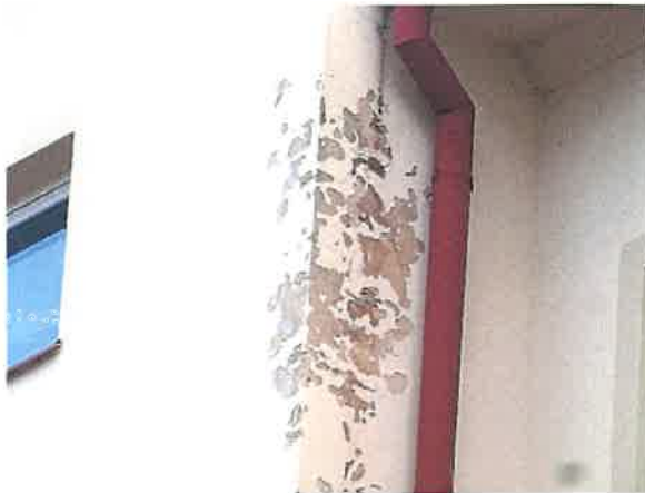
č. 26 – 27 Budova A, detaily poškození fasád
